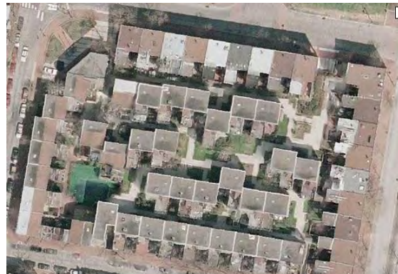
펜랜딩스퀘어 주거단지(로우하우스 철거 후 기존 로우하우스의 도시 맥락적 질서에 부합하여 주거단지 재개발)
